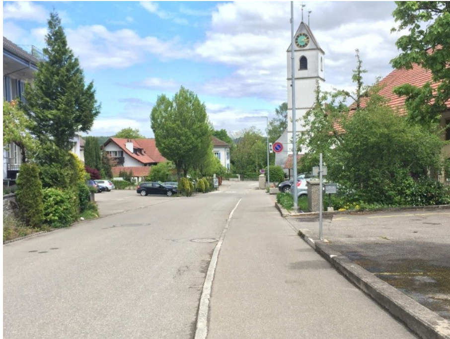
Abbildung 36: Hinterdorfstrasse über dem eingedolten Rybetstalbach (© google)
