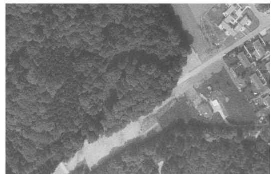
Abbildung 26: 1976, Friedhof und Parkplatz im Bau
