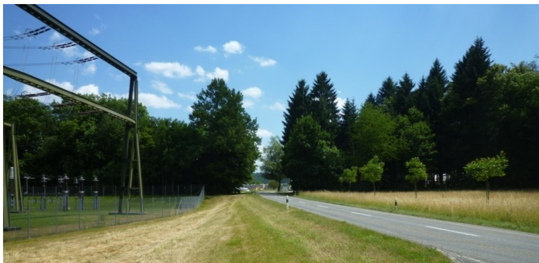
Abbildung 32: Im Areal Unterwerk Birr der nahezu unterbrochene Wildtierkorridor «Biretholz – Chesteberg»
